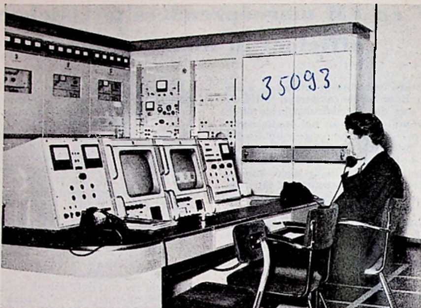
BEDIENINGSLESSENAAR EN EEN DEEL VAN DE NIEUWE TELEVISIEZENDER. ondergebracht op de 16e verdieping van de Radiatoren te IJsselstein
